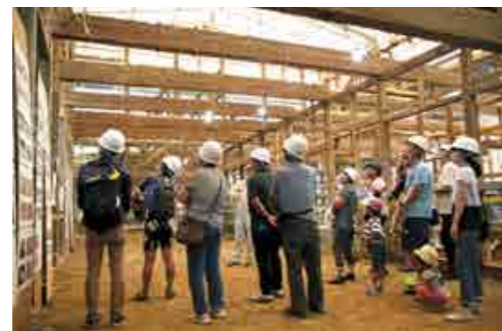
修復作業中の旧吹屋小学校校舎
