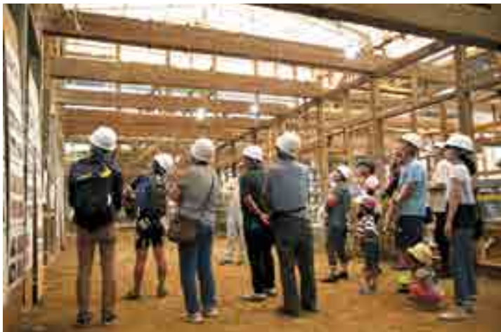
修復作業中の旧吹屋小学校校舎
