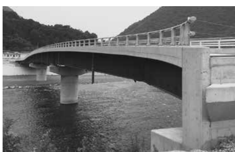
市道上小瀬1号線橋梁工事
