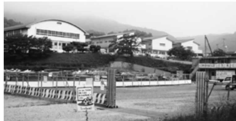
施設全景とリニューアル中の体育館
