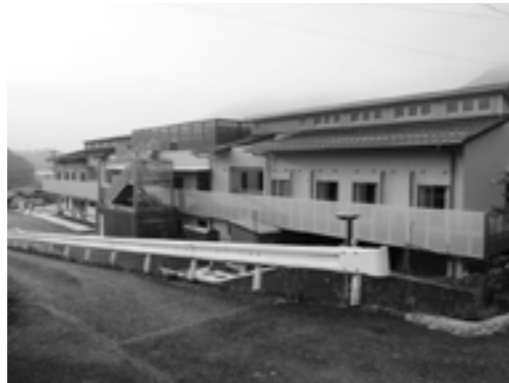
工場中の高梁市養護老人ホーム
