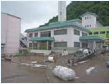
浸水したクリーンセンターの全景
