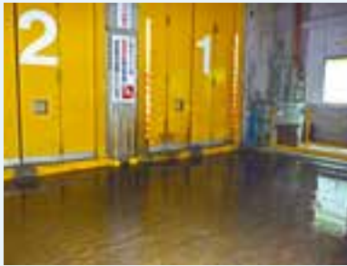
浸水したクリーンセンター内のプラットフォーム
