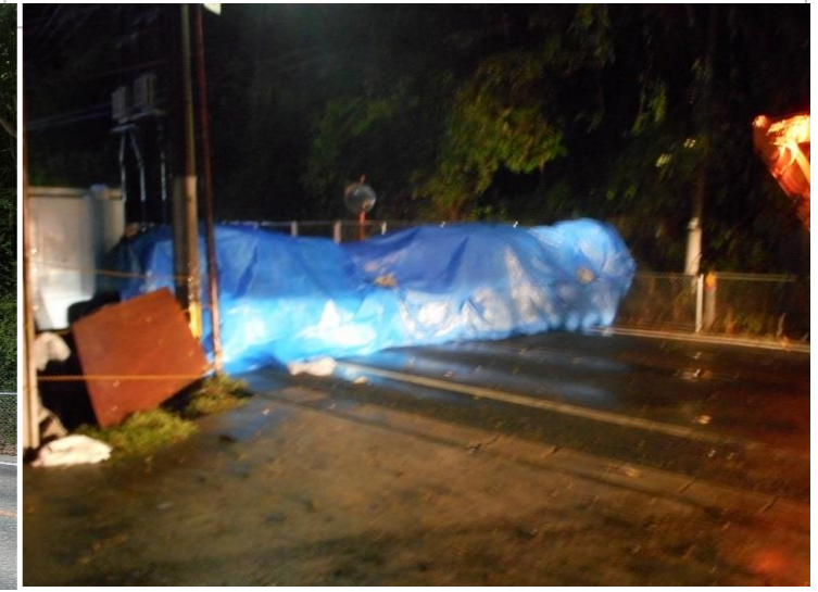
22時50分頃 国道313号土のう(陸閘代替)設置状況 (高梁 4.69m 成羽 3.96m 放流量 2,137t)
