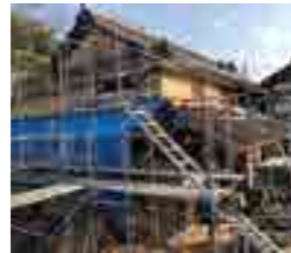
再生工事中(平成30年12月)
