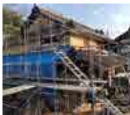
再生工事中(平成30年12月)
