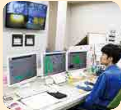
焼却炉の運転状況などをコンピューターシステムで確認
