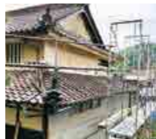
工事が続く西仲田邸
