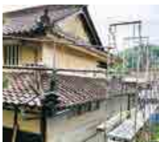
工事が続く西仲田邸
