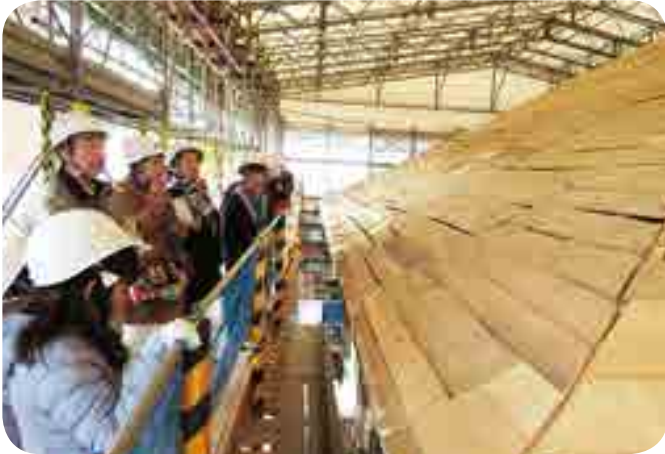
旧吹屋小学校の工事現場を見学
