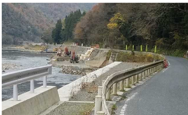
▲災害復旧と拡幅工事が進む新見川上線(用瀬付近)
