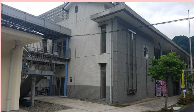
▲庁舎東側(水色の柱の所が入り口)
