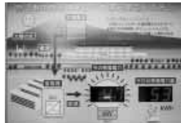
太陽光発電システムの掲示板。その日の発電電力量を表示。
