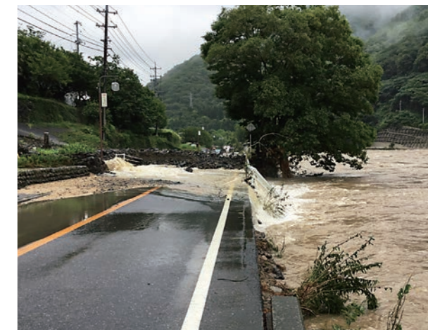
国道313号へ激しく流れ出る境谷川（落合町阿部地内）
