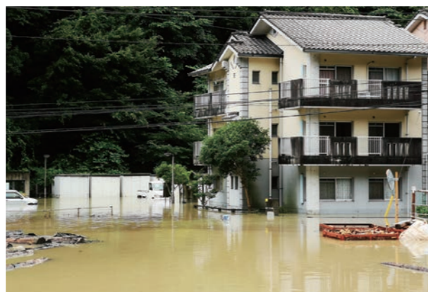
浸水した市営長屋住宅
