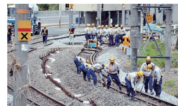
JR伯備線復旧作業の様子（7月21日、松山地内）
