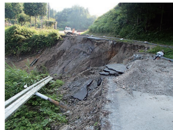
農道仁賀上大竹線(復旧前)
