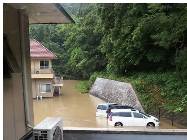
浸水した老人福祉施設（落合町福地地内）
