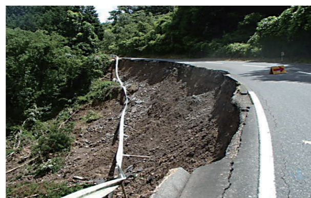
崩落した農道仁賀上大竹線(川上町上大竹地内)
