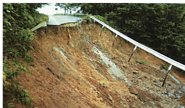
崩落したかぐら街道(松原町松岡地内)
