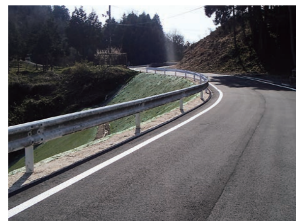
農道仁賀上大竹線(復旧後)
