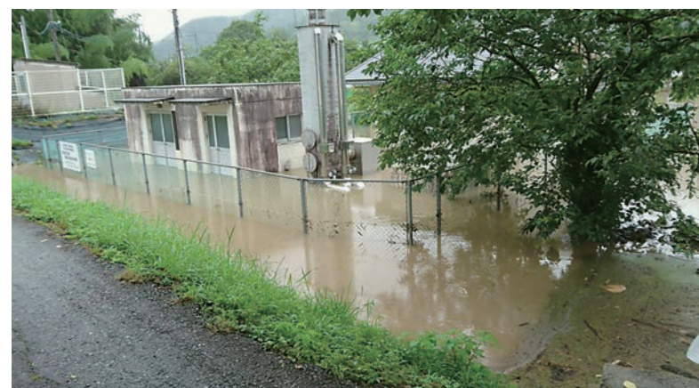
浸水した川面水源池
