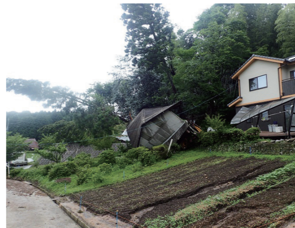
地すべりにより崩壊した民家（川上町高山地内）
