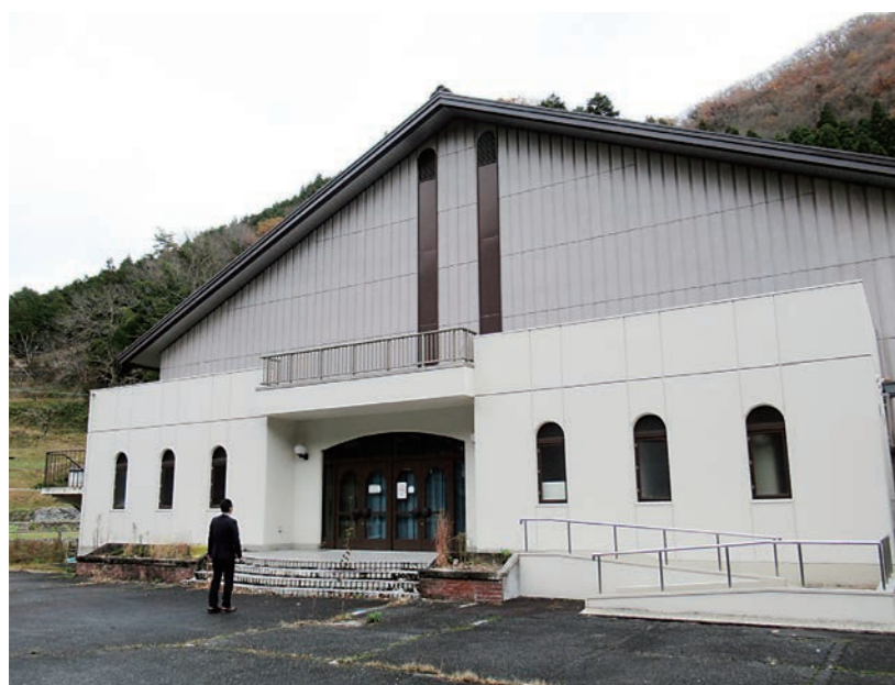
避難所になった旧備中中学校の体育館＝高梁市成羽町布寄
