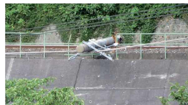
倒壊した送電柱（津川町今津地内）
