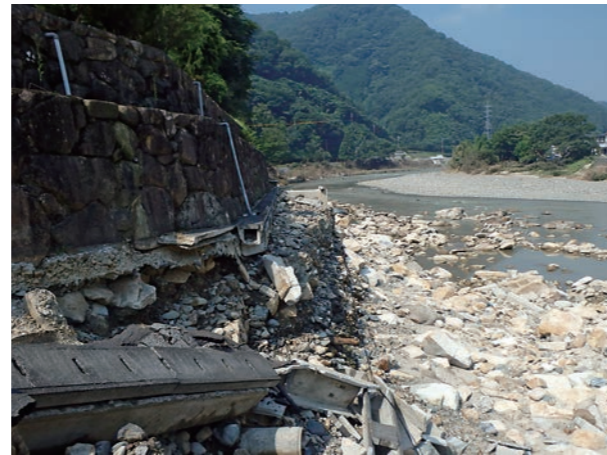
崩落した市道小瀬1号線（落合町阿部地内）
