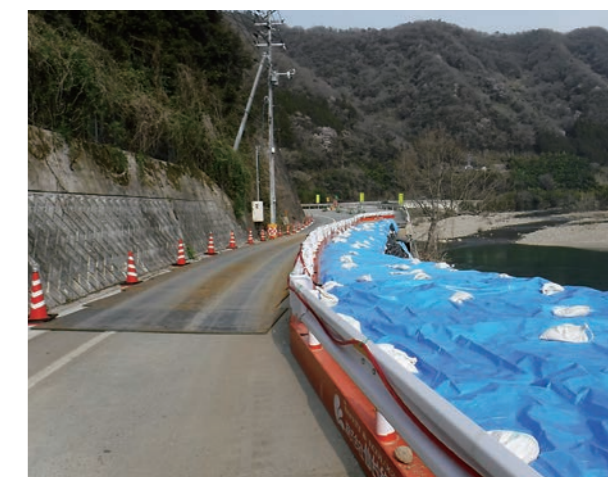
応急復旧した市道玉川落合線
