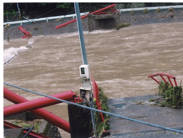
流失した用瀬橋（備中町志藤用瀬地内）
