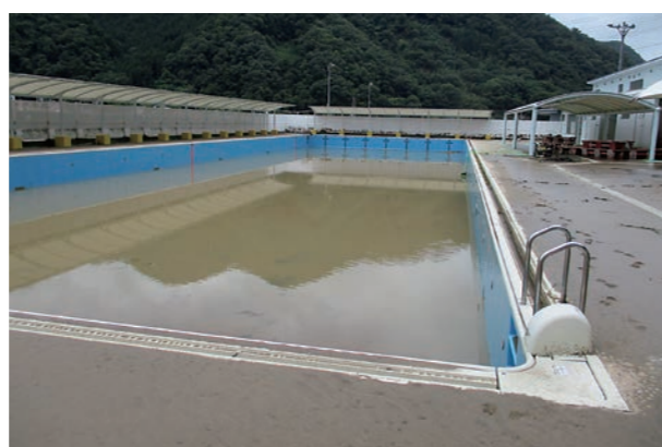
浸水した高梁市民プール
