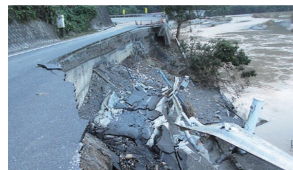
崩落した市道玉川落合線
