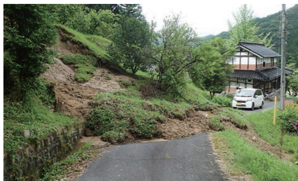
市道への土砂崩落（巨瀬町地内）
