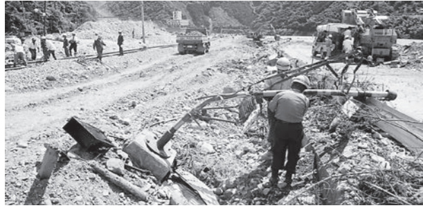
伯備線の復旧工事を行う日本国有鉄道(昭和47年撮影、松山地内)
