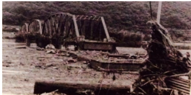
玉川橋(昭和47年撮影、松山地内)
