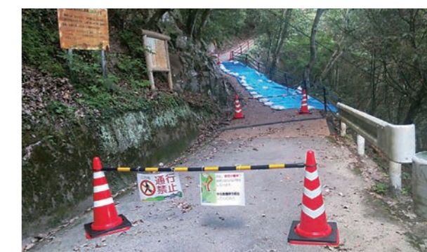
崩落した備中松山城登山道
