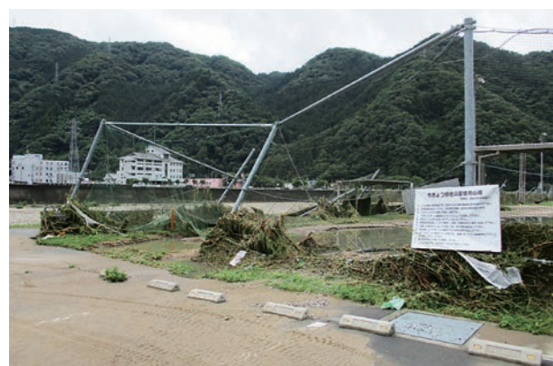
浸水したききょう緑地
