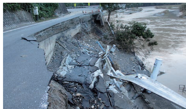
崩落した市道玉川落合線（玉川町玉地内）
