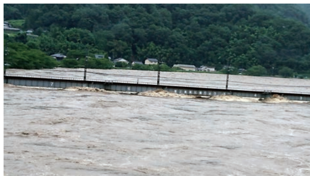
JR伯備線橋梁の様子（川面町地内）
