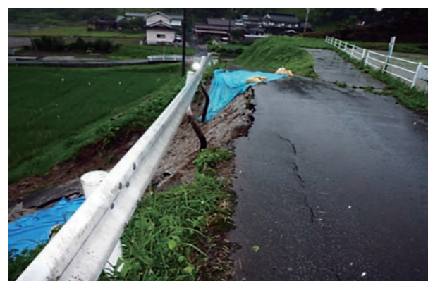
堤体が崩壊した西本池(中井町西方地内)
