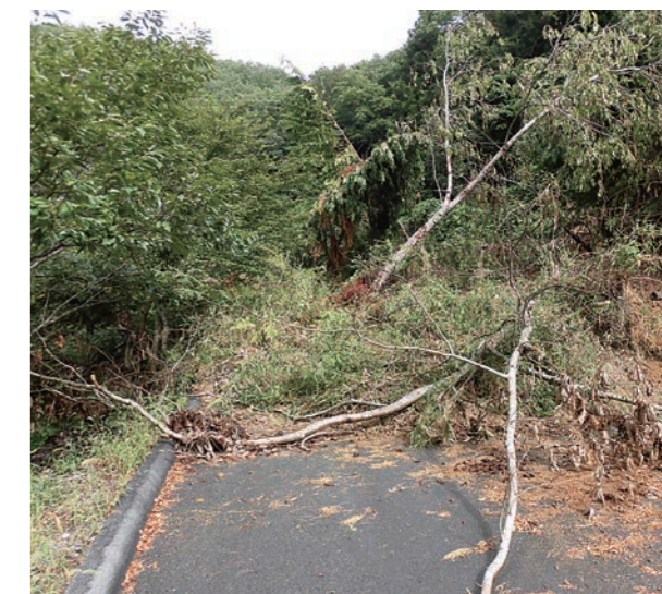
土砂が崩落した市道中井上野線（中井町西方地内）
