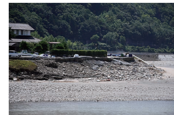
崩落した高梁市斎場前の護岸（段町地区内）
