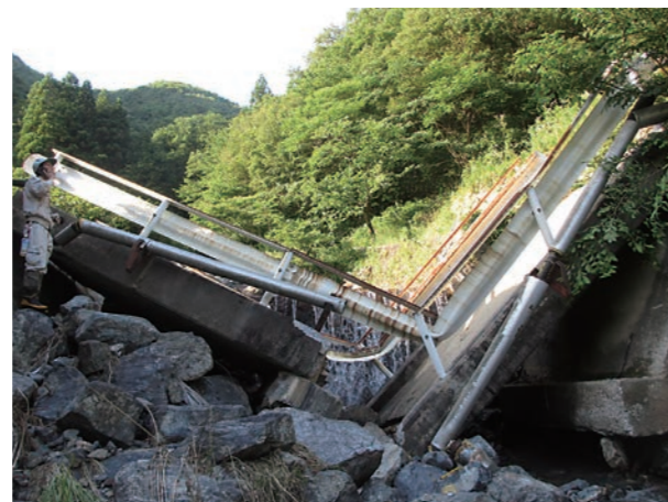
落橋した境谷橋（落合町阿部地内）
