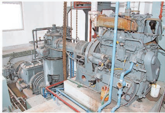
豪雨時に何らかの不具合が生じ、稼働しなかった排水ポンプ
