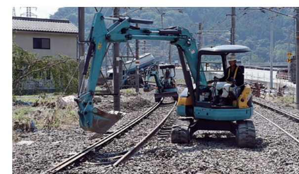
JR伯備線復旧作業の様子（7月14日、松山地内）
