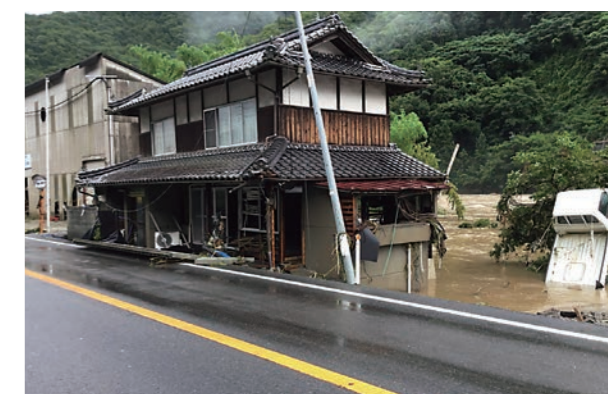
成羽川の激流により破損した民家と車両（落合町阿部地内）
