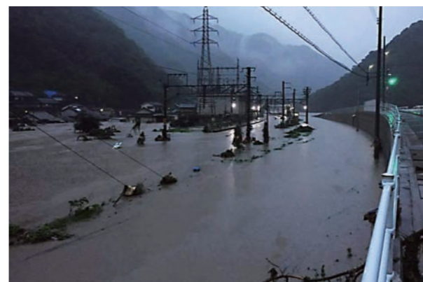
浸水したJR備中広瀬駅（=7月7日7時ごろ）
