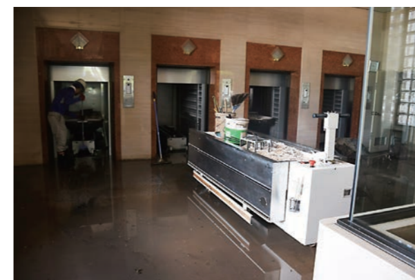
浸水した高梁市斎場
