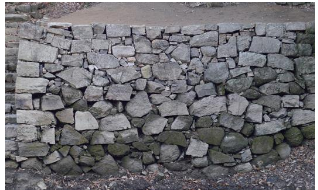
石垣解体修理 修理後の状況
