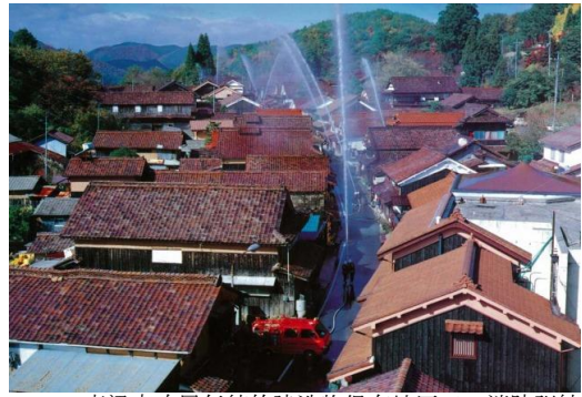
高梁市吹屋伝統的建造物保存地区での消防訓練
