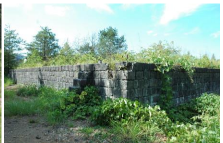
沈殿池跡の現況
