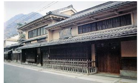
高梁市商家資料館(元池上醤油店)(本町)
