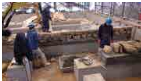
割石積布基礎の再構築
