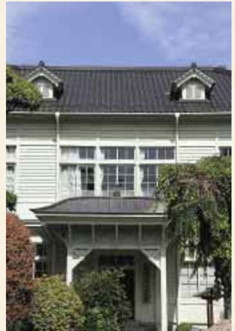
旧高梁尋常高等小学校本館。現在の高梁市郷土資料館。天井を高くとり、正面ポーチを中心に、ほぼ左右対称の木造建築。明治から大正にかけての学校建築の傑作。市指定重要文化財。
