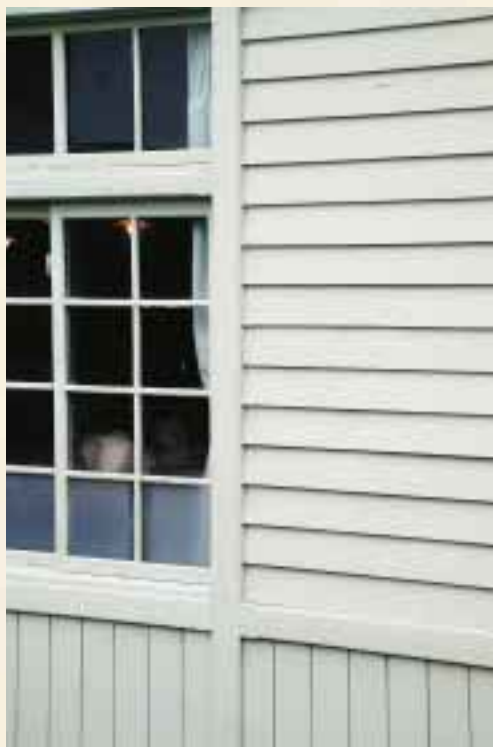
窓上下の梁に切り込みが見られる。「面取り」である。窓の下に連なる縦板部分を「腰板」。その組み方を「豎羽目」。窓の右、段々模様に見える横板部分を「下見板張り」という。「下見板張り」は江戸時代までの日本にはなかった様式。擬洋風建築の特徴のひとつでもある。
