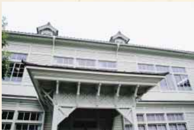
玄関ポーチは銅葺屋根。独特の木組みが印象的。竣工当時は、軒の高さや洋風の外観に注目が集まったことであろう。大屋根の上に見えるのがドーマーウィンドウ。
