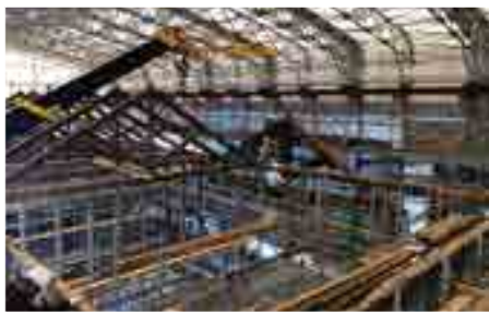
屋根トラス(骨組み)の再構築
