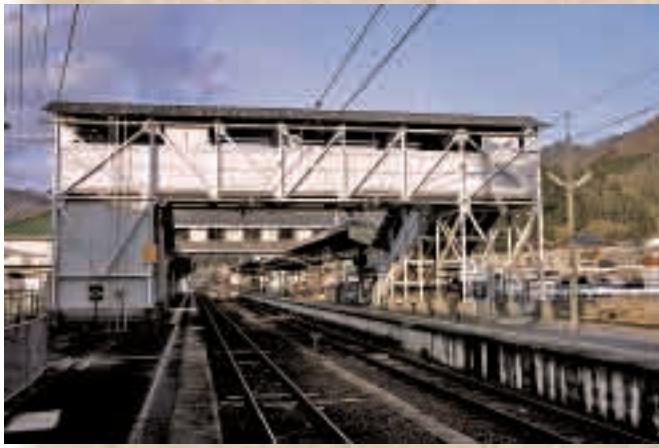
人道跨線橋の支柱は、山陽線の熊山駅や金光駅に残る鑄鉄製から古レールへと移り変わりました。備中高梁駅跨線橋の2番線側には「1964-3」のプレートが貼られています。
