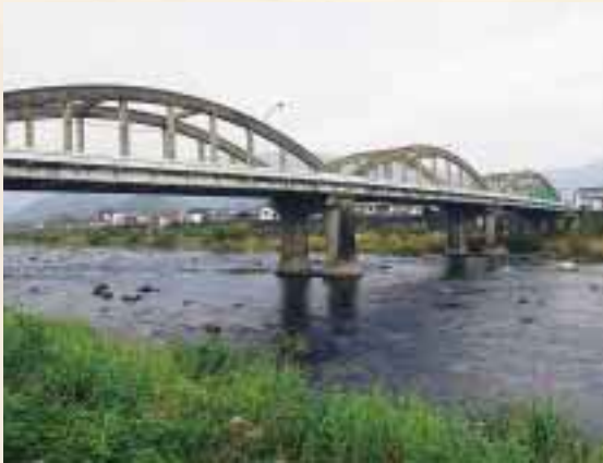
やさしい曲線を描く総門橋のコンクリートアーチ。がっしりとした橋脚が無骨に思えます。
