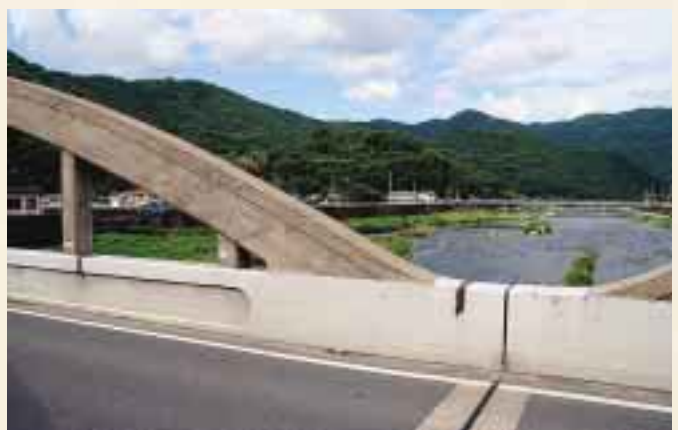
アーチリブと下弦材につけられた帯状の凹みがコンクリートの平板さと重苦しさを和らげます。
