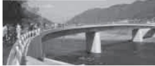
完成したあいあい橋
