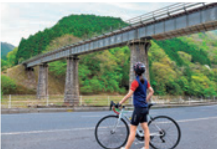
④ 美作河井駅～知和駅間に架かる石造りの橋梁
