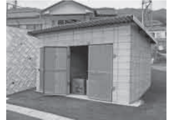
新設されたごみステーション
