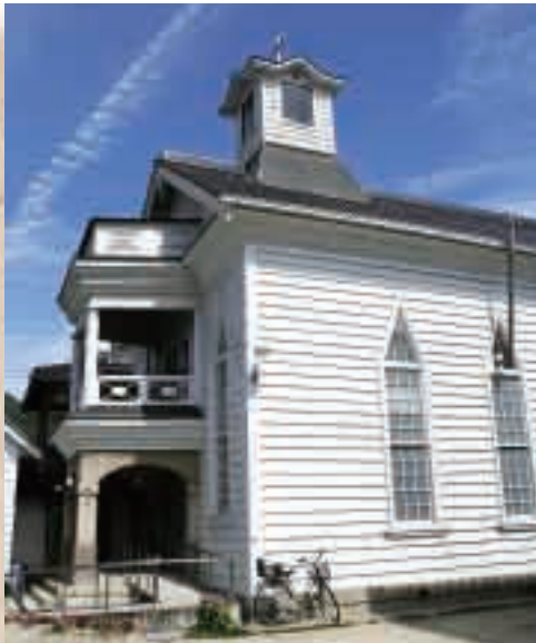
鐘楼は、旧札幌農学校演武場の時計台を手本にしたといわれ、岡山県重要文化財の指定を記念して明治28年に取り付けられました。
