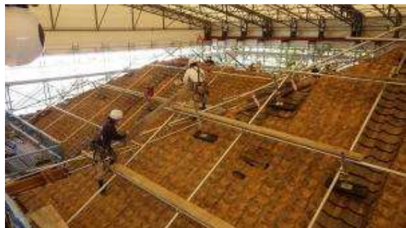
保存修理のため校舎解体
