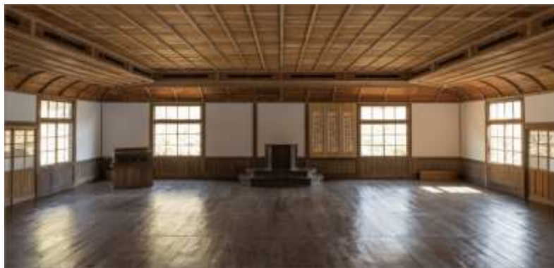
完成した二重折り上げ棹縁天井
