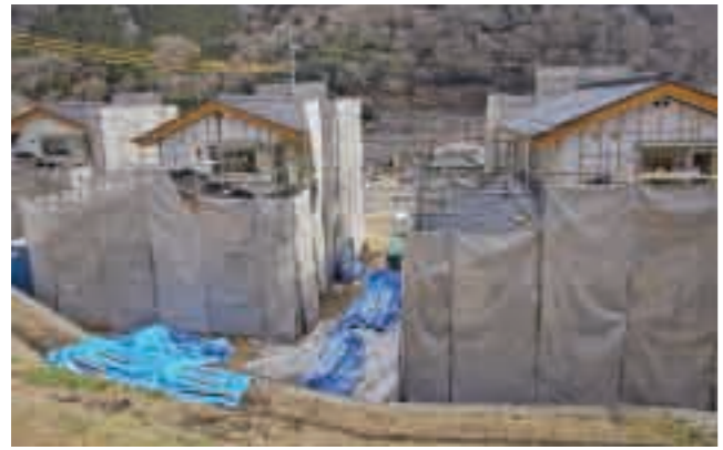
建設中の子育て世帯向け住宅
