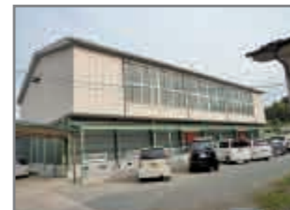
宇治小学校 屋内運動場耐震補強工事 事業費 48,594千円
