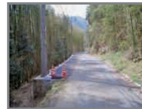
市道田原阿部山線改良工事 (成羽町阿部山地区)
