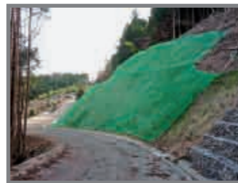
市道下合3号線改良工事 (備中町西油野地区)
