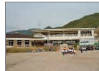
落合幼稚園 園舎耐震補強工事 事業費 24,000千円
