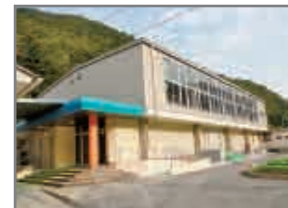
津川小学校 屋内運動場耐震補強工事 事業費 23,870千円
