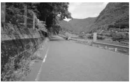
幅員が狭い県道新見川上線(川上町地内)
