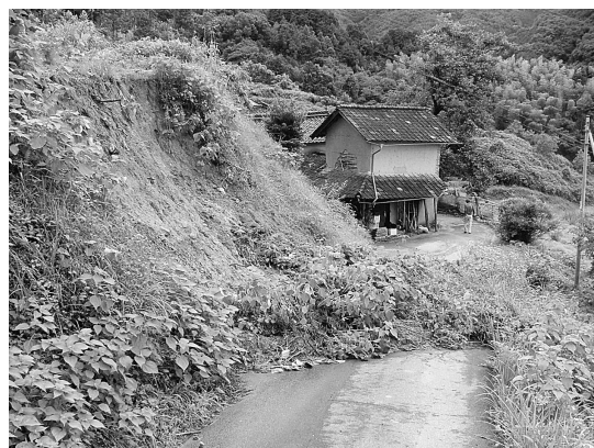
私道の崩土現場（有漢町内）
