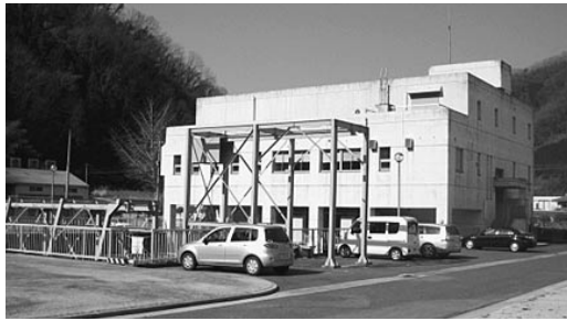
高梁雨水ポンプ場
