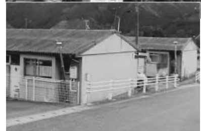
老朽化した市営天神ヶ丘住宅
