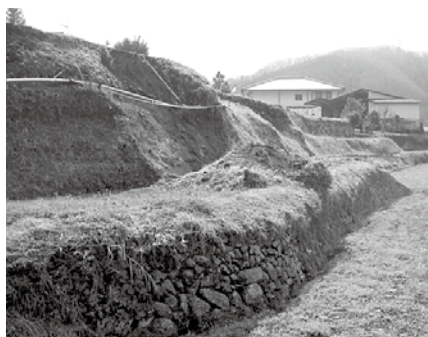
平成24年の大雨による災害の傷跡はまだまだ深い
