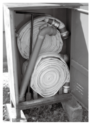
消火器具とボックス
