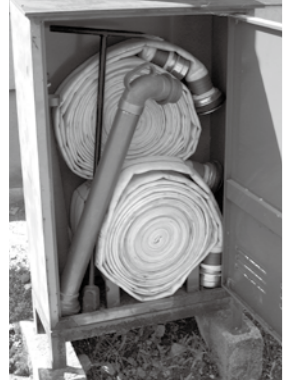
消火器具とボックス
