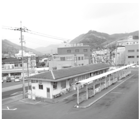
新図書館建設予定地
