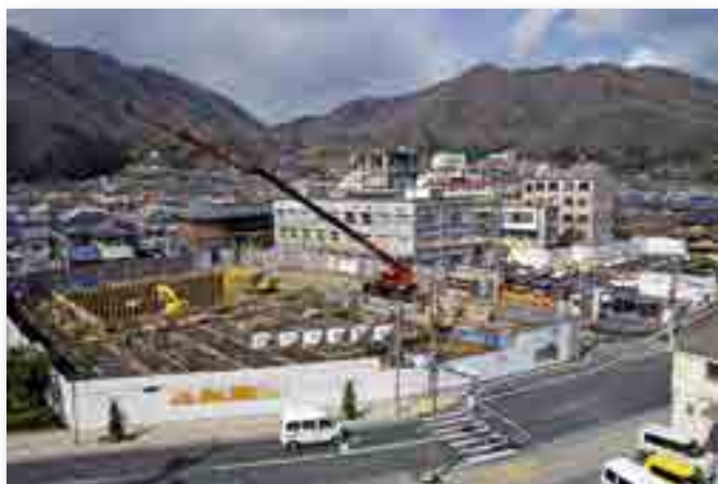
▲ 工事中の様子 (平成26年3月6日撮影)
