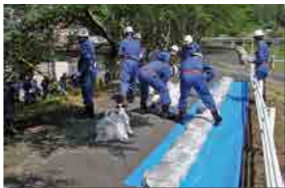
河川の増水に備え土のうを積み消防団員
