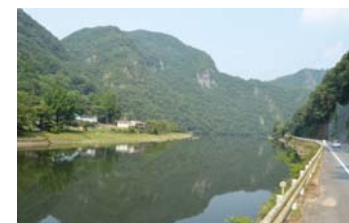
主要地方道新見川上線の沿道
