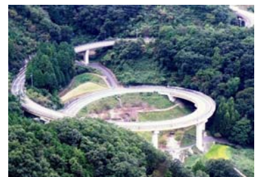
国道 484 号愛宕ループ橋
