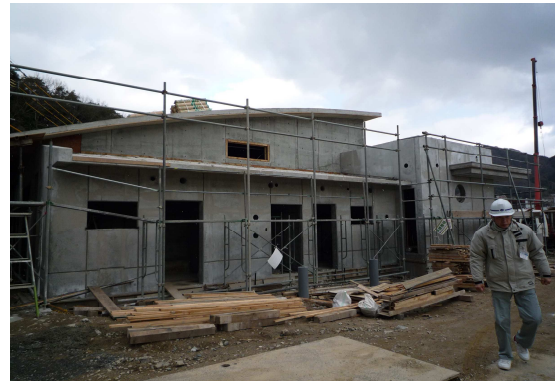
管理棟施工状況
