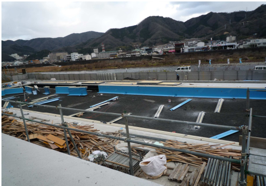
プール施工状況
