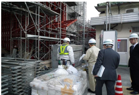
施工状況審査(現地)
