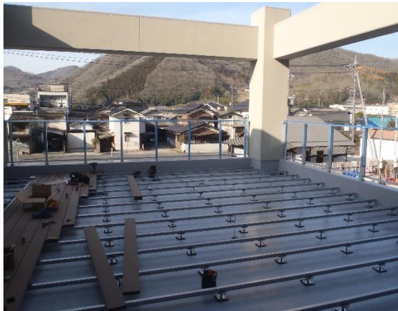
2階屋上 ウッドデッキ 現況
