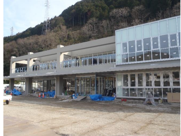
外部 北面 現況
