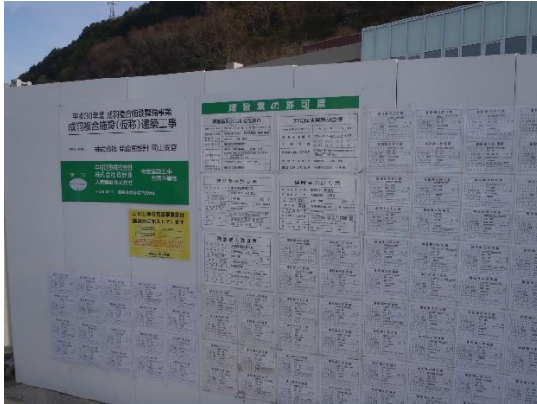
掲示物 建築工事 建設業許可標識、労災保険関係成立票、 建退共制度の適用標識、施工体系図
