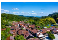
日本遺産に認定された吹屋の町並み
