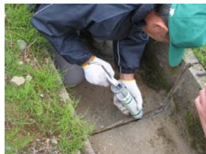
シーリング材充填
