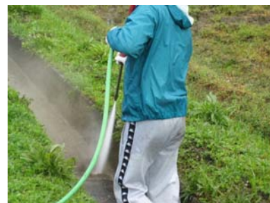
高圧洗浄機による 水路内の清掃
