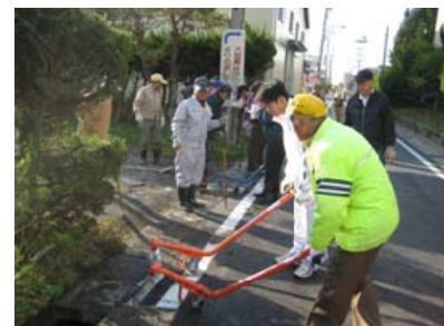
水路蓋の設置 (専用器具使用)
