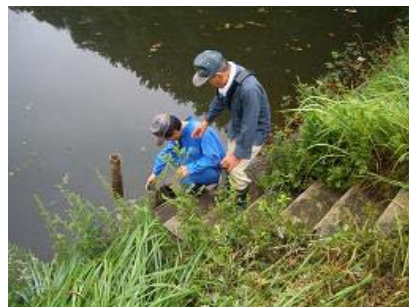
取水施設の点検
