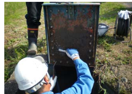
ゲートの補修状況
