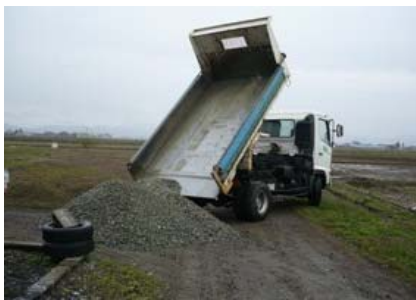
砂利の荷下ろし
