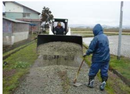
砂利の敷き均し
