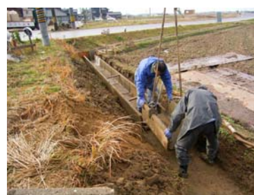
水路の再布設
