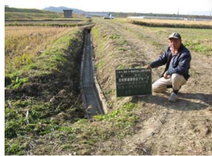
土側溝をコンクリート側溝に更新
