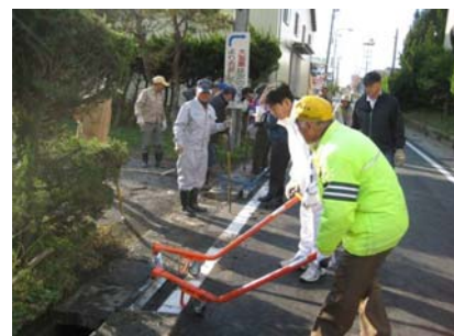
水路蓋の設置 (専用器具使用)
