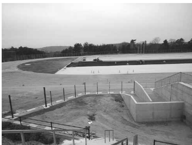
神原スポーツ公園改修工事の様子
