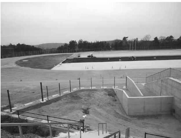
神原スポーツ公園改修工事の様子
