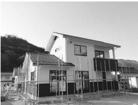
川上町地頭地内に建設中の地域優良賃貸住宅
