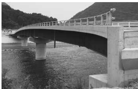
市道上小瀬1号線橋梁工事
